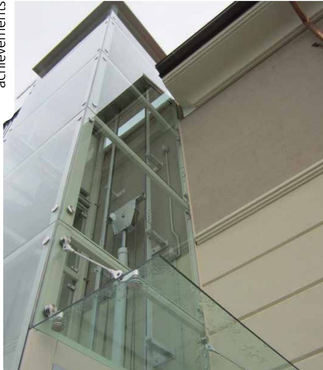
Copertura vano ascensore Elevator curtain wall
