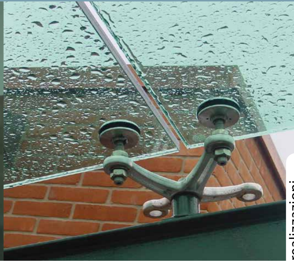
Dettaglio supporto Astra per copertura Astra support detail for roof installation
